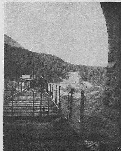
Abb. 6. Blick aus dem Sparsa-Tunnel vom Materialzug aus talabwärts auf den Crastatscha-Tunnel.
