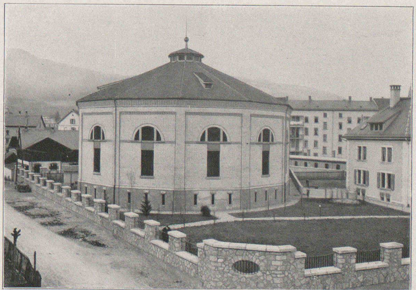
Schutzhaus für den Behälter in Delsberg.
