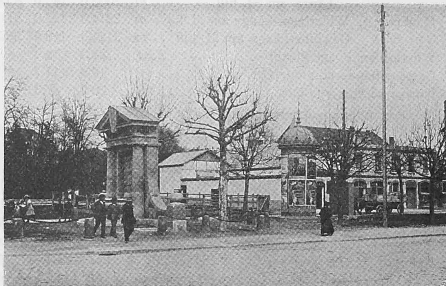
Abb. 1. Wandbrunnen; dahinter das runde Transformatorenhäusle und der vierseitige Schaltkasten.
