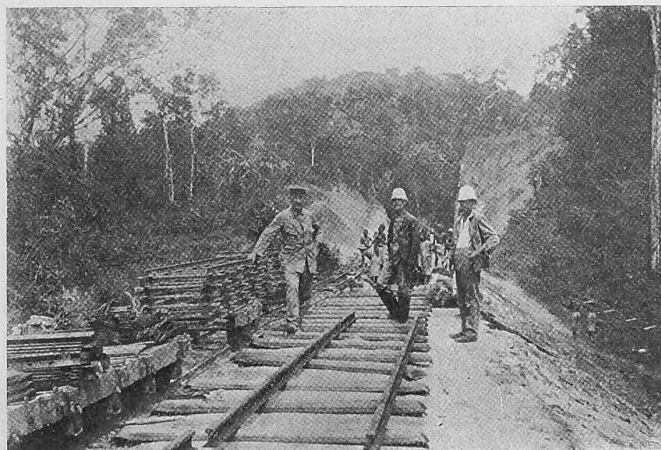
Abb. 15. Vorstrecken des Geleises.
