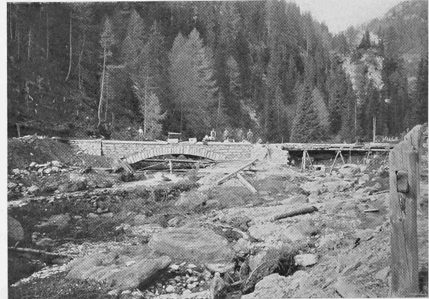
Abb. 14. Schergenbachbrücke bei Km. 14,7.
