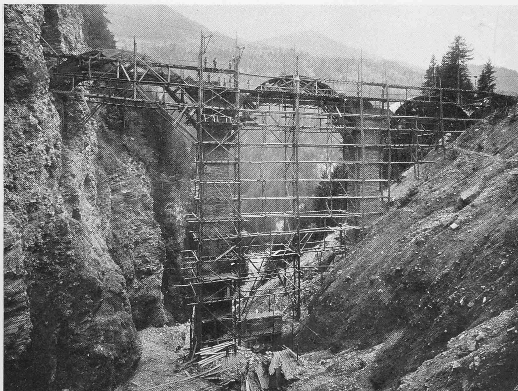
Unten: Der Castieler-Viadukt, 3 Bogen zu 25 m
