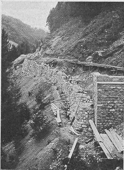
Abb. 5. Stützmauer Km. 3 831 / 015 (30. VI. 13).
