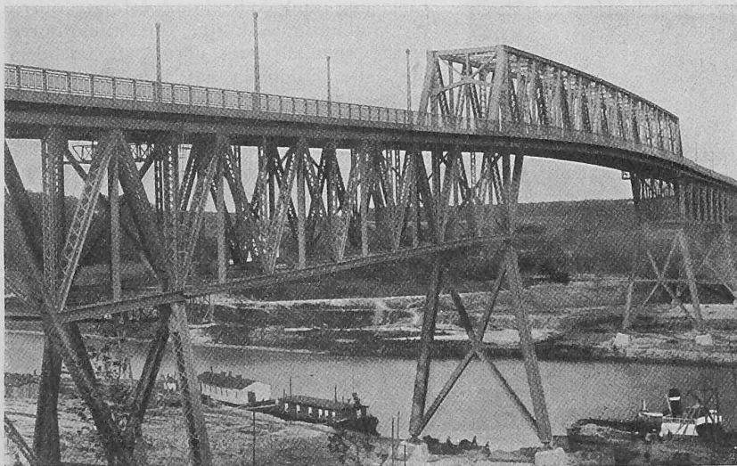
Abb. 10. Strassenbrücke über den Kaiser Wilhelm-Kanal bei Holtenau.
