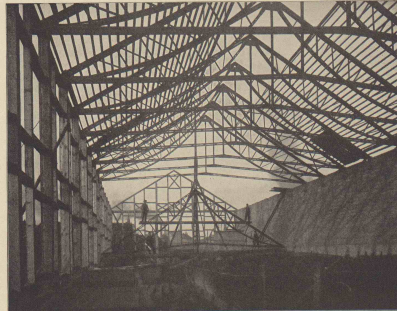
7. Vitralfabrik der Westphälischen Drahtindustrie in Hamm — Spannweite: 17,00 m
