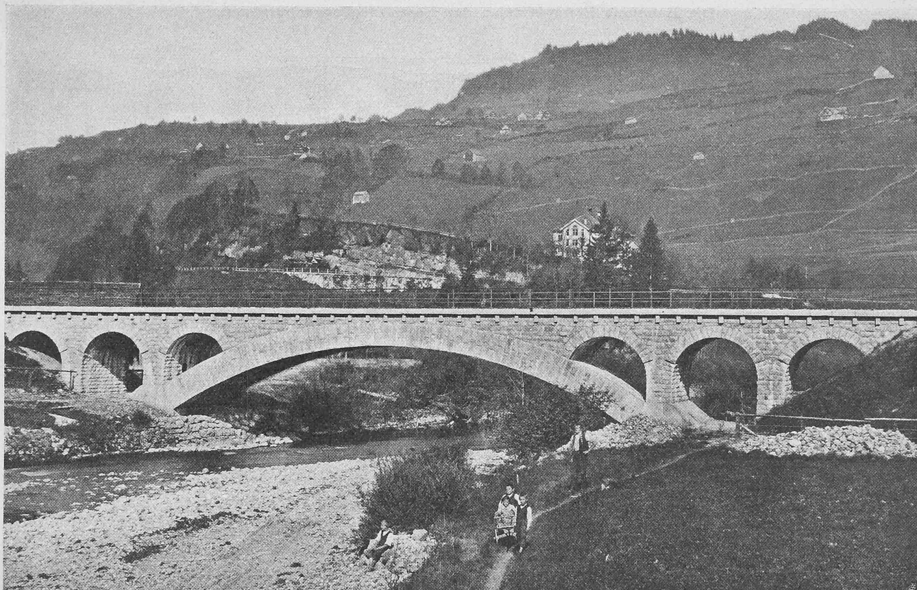
Abb. 19. Steinere Thurbrücke bei Km. 6,650 von 24,82 m Lichtweite. Ansicht von Süden, vom rechten Ufer.
