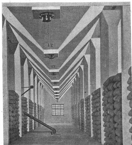
Inneres eines Getreide-Silo.
