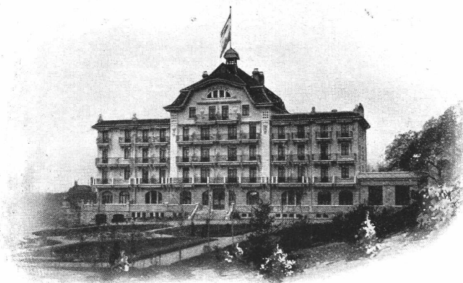
Chauffage central et installations sanitaires complètes.
