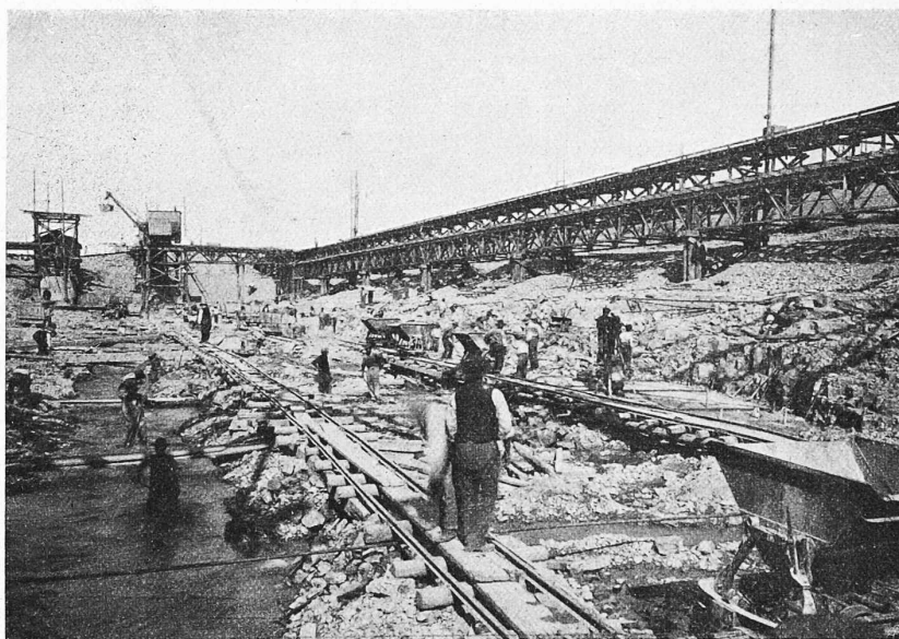
Abb. 80. Blick stromaufwärts in die Turbinenhaus-Baugrube (20. V. 1910).
