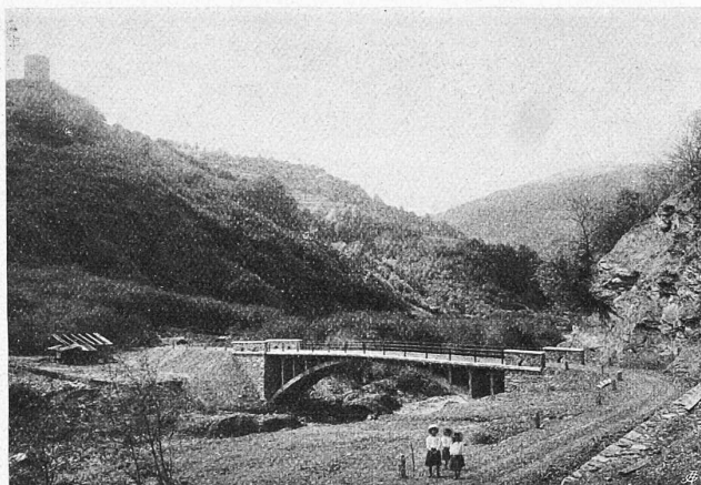
Abb. 11. Glennerbrücke talauswärts gesehen.
