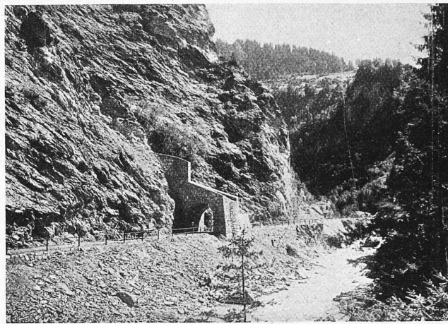
Abb. 7. Steinschlaggalerie im Rieiner-Tobel.
