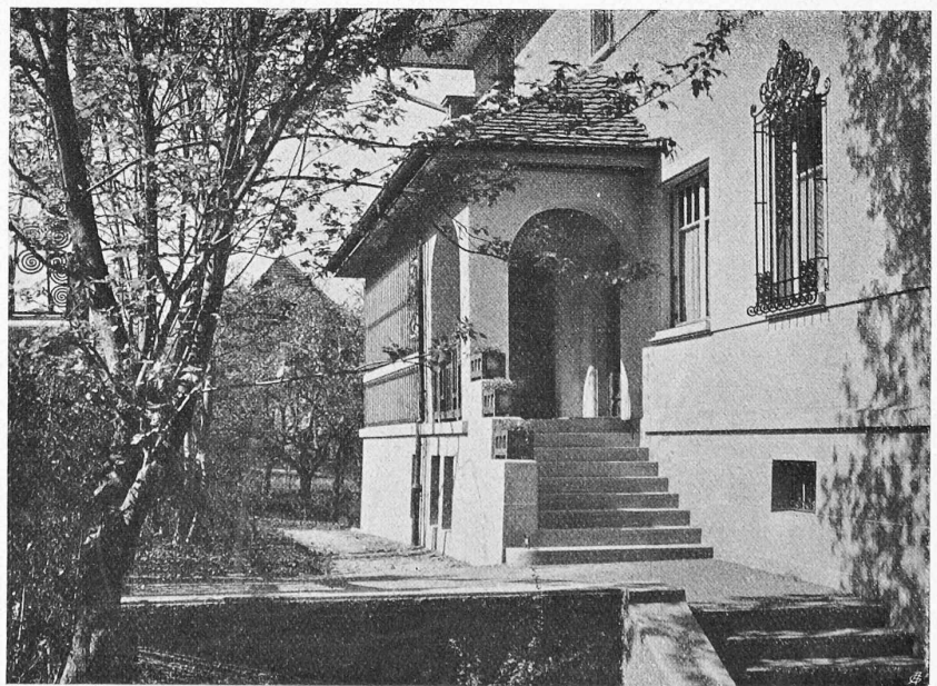
Abb. 7. Hauseingang an der Südwestfront (Strassenseite).
