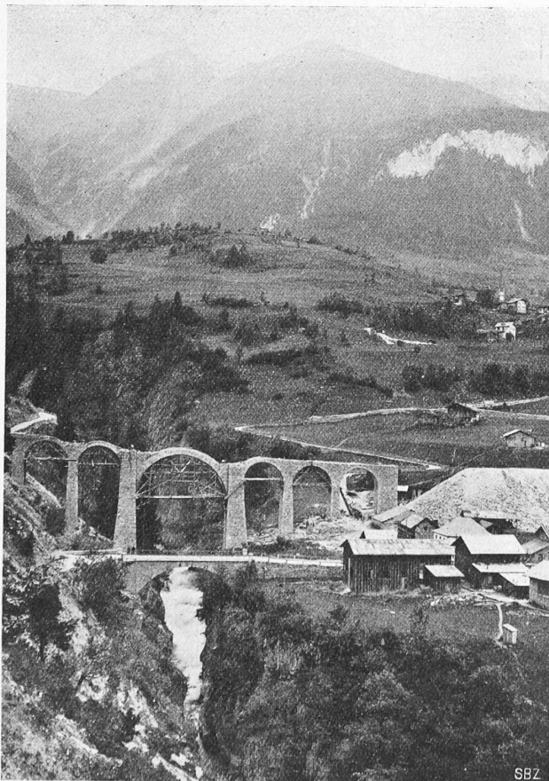
Abb. 11. Grengiols-Viadukt im Bau, Hauptöffnung 22 m.
