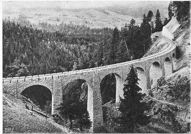
Abb. 10. Laxgraben-Viadukt oberhalb Grengiols.
