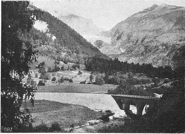
Abb. 9. Vieschergraben-Viadukt und Vieschergletscher.
