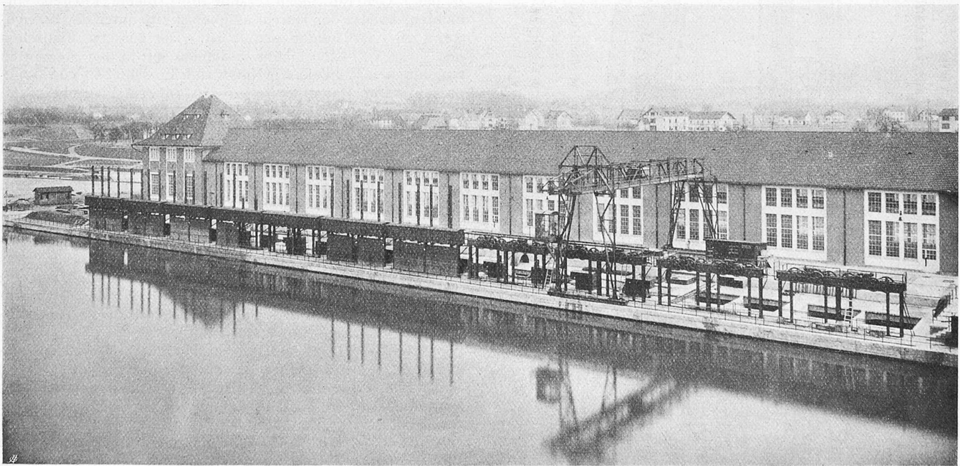
Abb. 3. Blick vom Stauwehr-Dienststeg auf Einläufe und Turbinenkammern des Kraftwerkes Augst (26. II. 1913).
