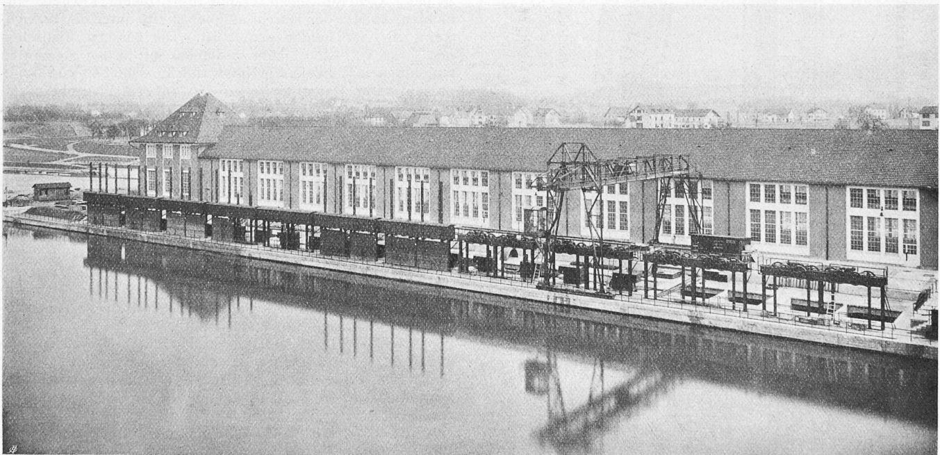
Abb. 3. Blick vom Stauwehr-Dienststeg auf Einläufe und Turbinenkammern des Kraftwerkes Augst (26. II. 1913).
