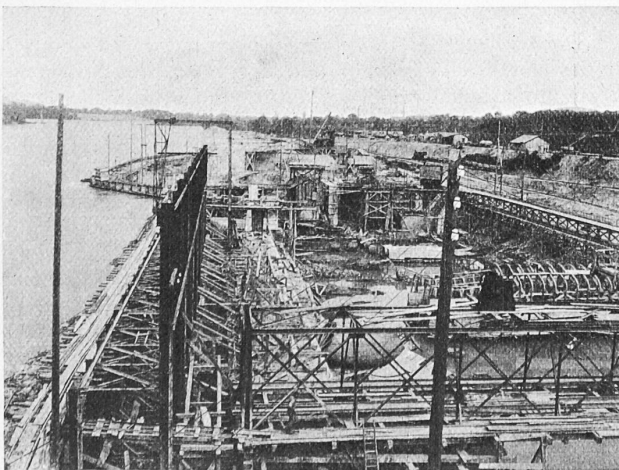
Abb. 7. Montierung der Einlaufschützen-Führungen (7. IX. 10).
