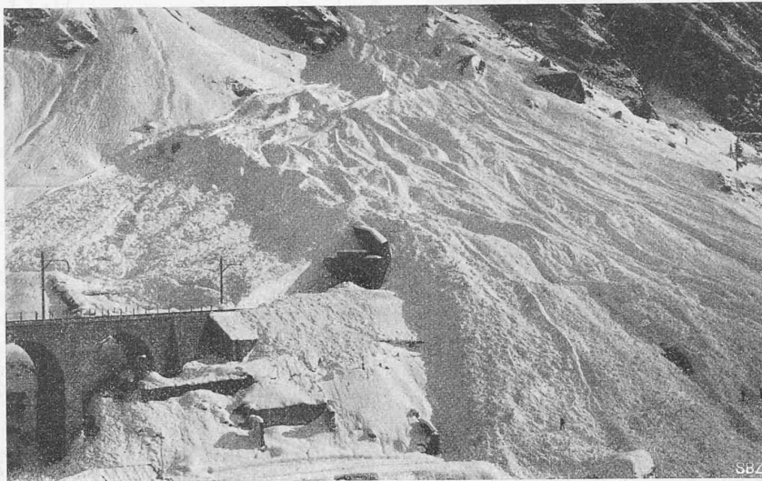
Abb. 12. «Rote Lawine» 1913, Lanza-Viadukt und oberes Rotlauentunnel-Portal.
