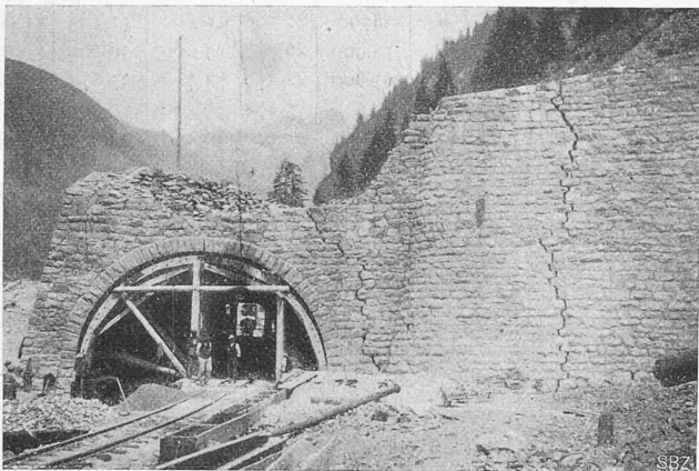
Abb. 31. Stockgraben-Galerie, Portal Seite Brig Ende 1911.
