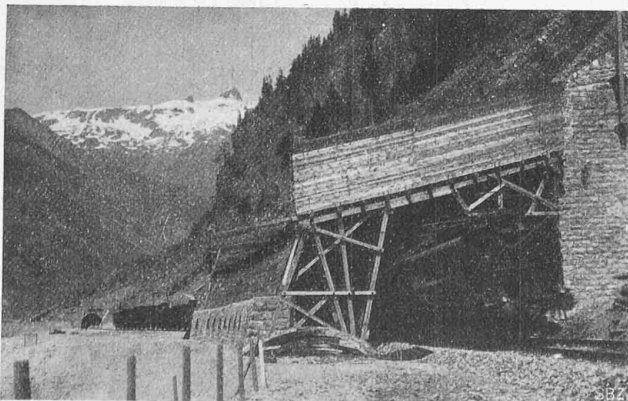
Abb. 34. Prov. Holzgalerie im Stockgraben-Lawinezug.
