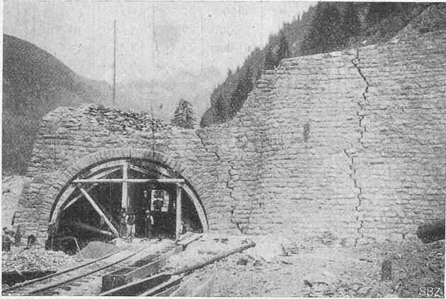
Abb. 31. Stockgraben-Galerie, Portal Seite Brig Ende 1911.
