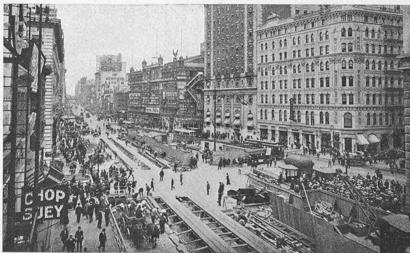
Abb. 5. Bohlen-Abdeckung zum Bau der Untergrundbahn (7. Av., 42. Str.).
