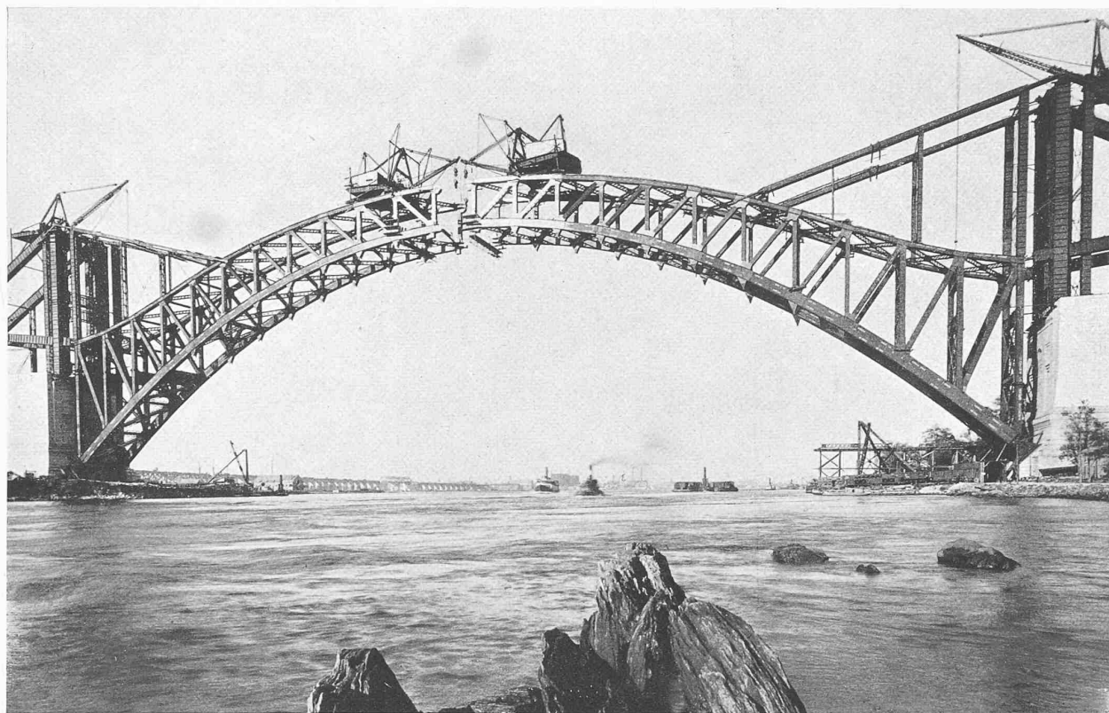
Abb. 17. Am 29. September 1915, unmittelbar vor Bogenschluss.
