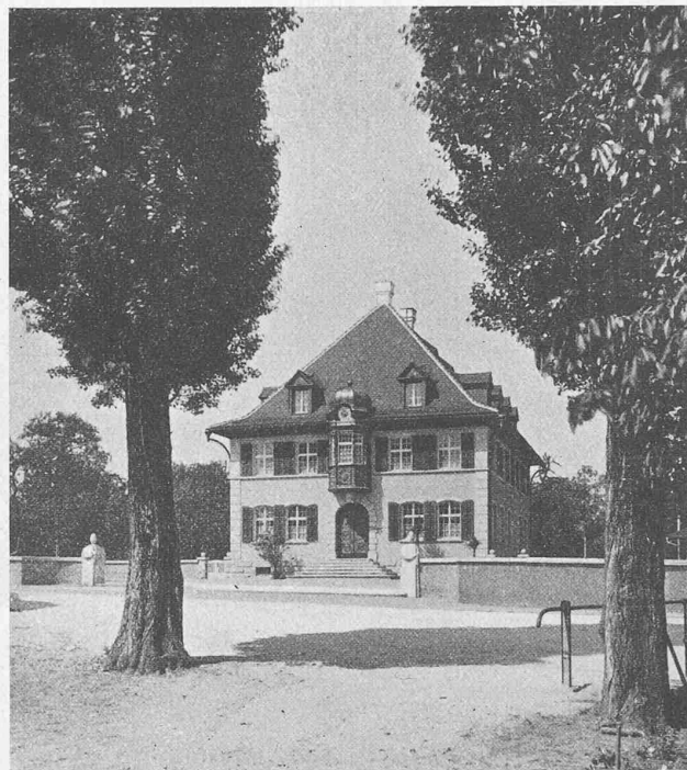
Abb. 5. Ansicht aus Nordost.
