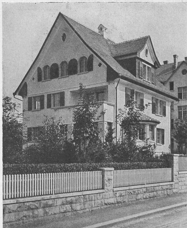
Abb. 22. Streulistr. 54. Ansicht von der Wotanstrasse, von Westen.
