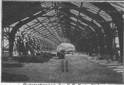
Gutschuppen der S. B. B. in Biel.
