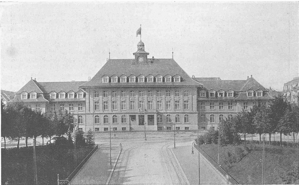
OBEN: HAUPTANSICHT IN DER AXE DER KORNHAUSSTRASSE
