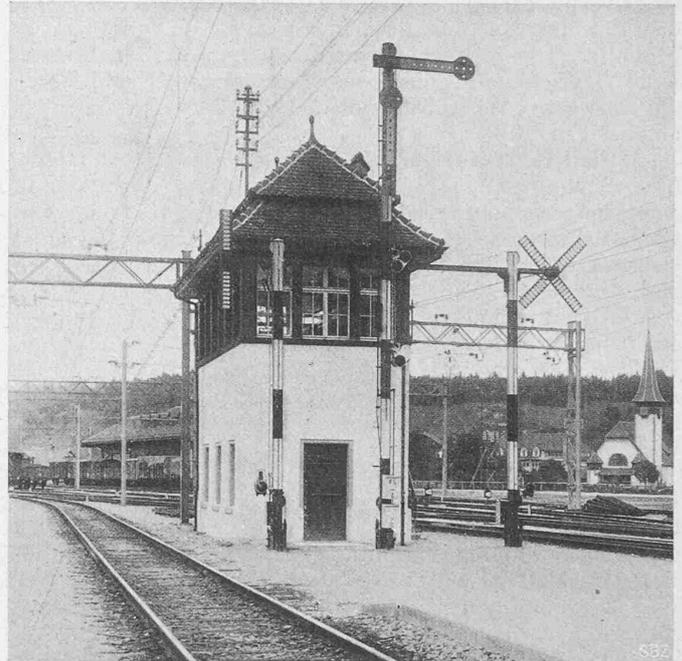
Abb. 7. Stellwerk II, Ausfahrtsignal  $F^{1/2}$  und Rangiersignale.
