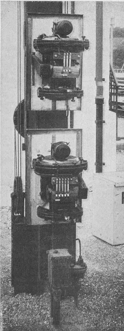
Abb. 6. Signalantriebe am Ausfahrtsignal F<sub>1/2</sub>.
