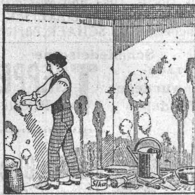
Wasserdurchlässige Stellen in Böden und Wandputz werden mit schnellbindender „SIKA“ verdichtet.
