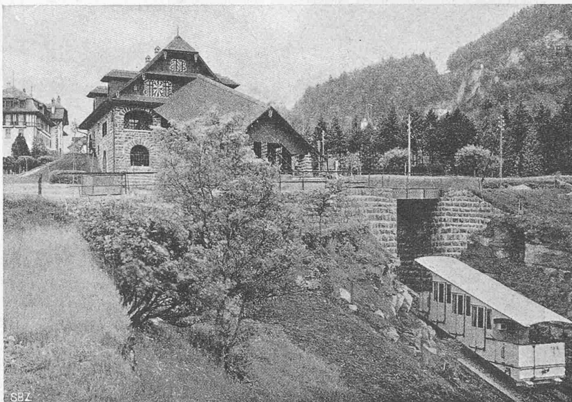
Abb. 6. Station Seelisberg der Treib-Seelisberg-Bahn.
