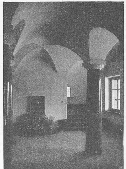
Abb. 8. Eingangshalle und Treppenaufstieg.
