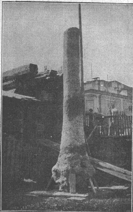
Nebenstehend: Ausgegrabener Press-Betonpfahl bei einer Foundation in St. Moritz.
