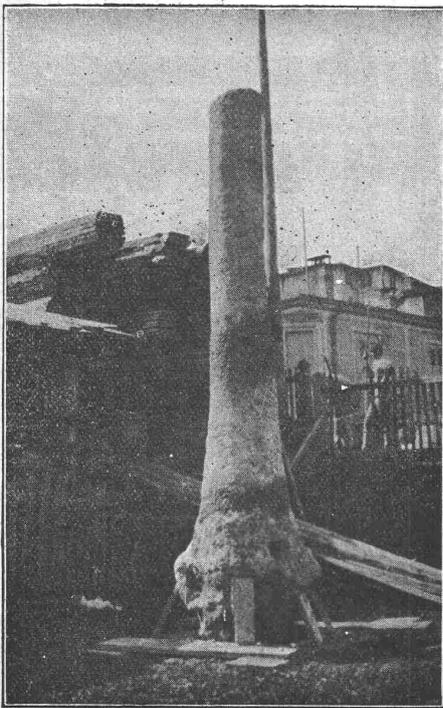
Nebenstehend: Ausgrabener Press-Betonpfahl bei einer Fundation
