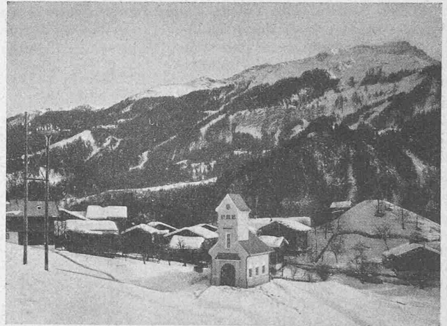
Abb. 14. Bedienungshäuschen über dem Wasserschloss in Lüen.
