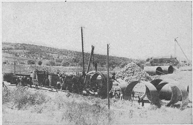
Abb. 37. Im Werk vernietete Rohrschüsse auf der Baustelle.
