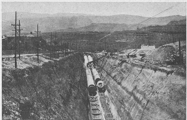
Abb. 38. Rohrleitungsmontage; Schüttgerüst für die Betonierung, die der Montagestelle auf rund 30 m Abstand folgt.
