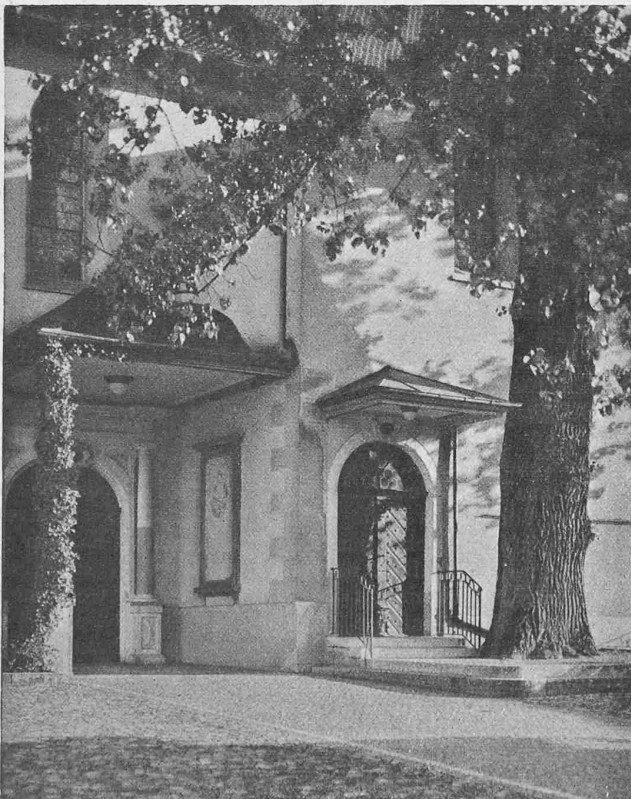
Abb. 2. Nordwestlicher Kircheneingang und Emporencgang.
