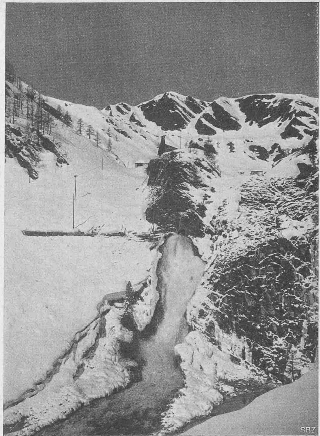
Abb. 7. Ausmündung des Grundablass-Stollens in den Fossbach (6. III. 1917).
