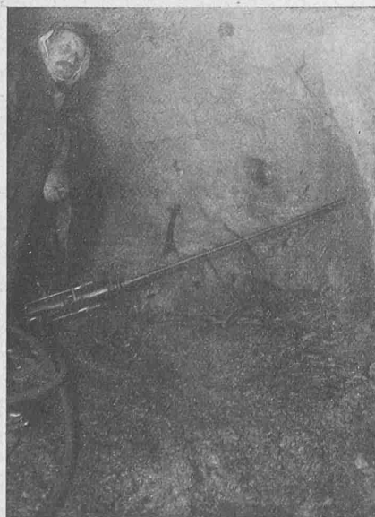
Abb. 6. Brust des Anstichstollens am 2. II. 1917.
