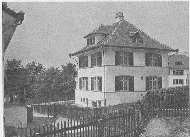
Abb. 14. Einfamilienhaus F, von Südosten.
