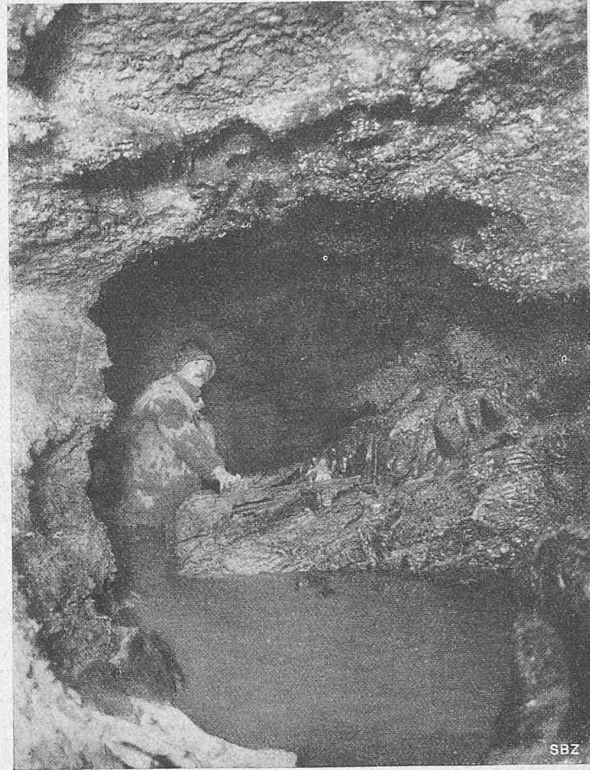
Abb. 26. Kluft beim Eintritt ins Kimeridge bei Km. 4,470.
