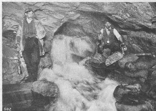
Abb. 23. Zufluss aus Kluft C, am 5. April 1914.
