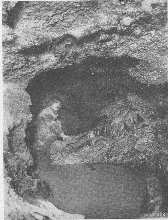
Abb. 26. Kluft beim Eintritt ins Kimeridge bei Km. 4,470.
