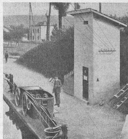
Abb. 2. Antriebswinde mit Transformatorstation.
