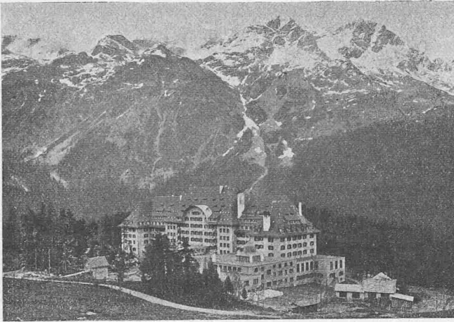
Abb. 3. Nordwestansicht mit dem Küchenbau.
