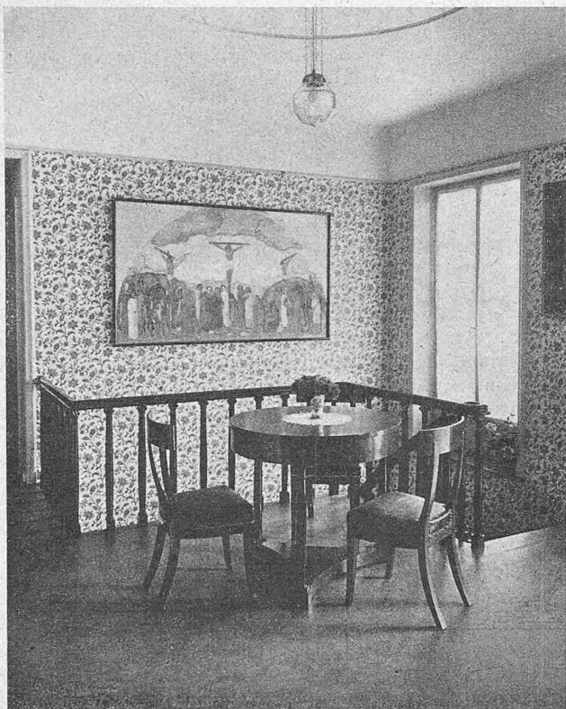
Abb. 9. Treppen-Vorplatz im Obergeschoss.
