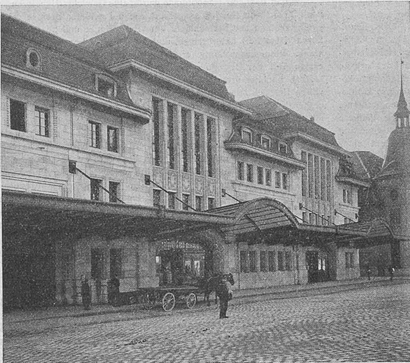
Abb. 7. Westlicher Flügel des Aufnahmegebäudes.
