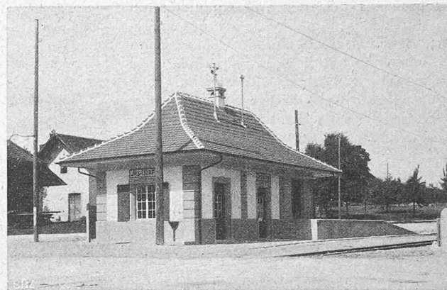
Abb. 17. Station Ins-Dorf der Biel-Täuffelen-Ins-Bahn.
