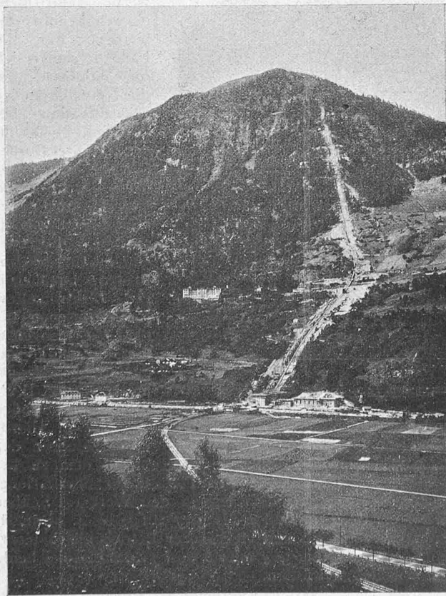
Abb. 6. Kraftwerk Ritom. Gesamtbild, vom 2. September 1918.
