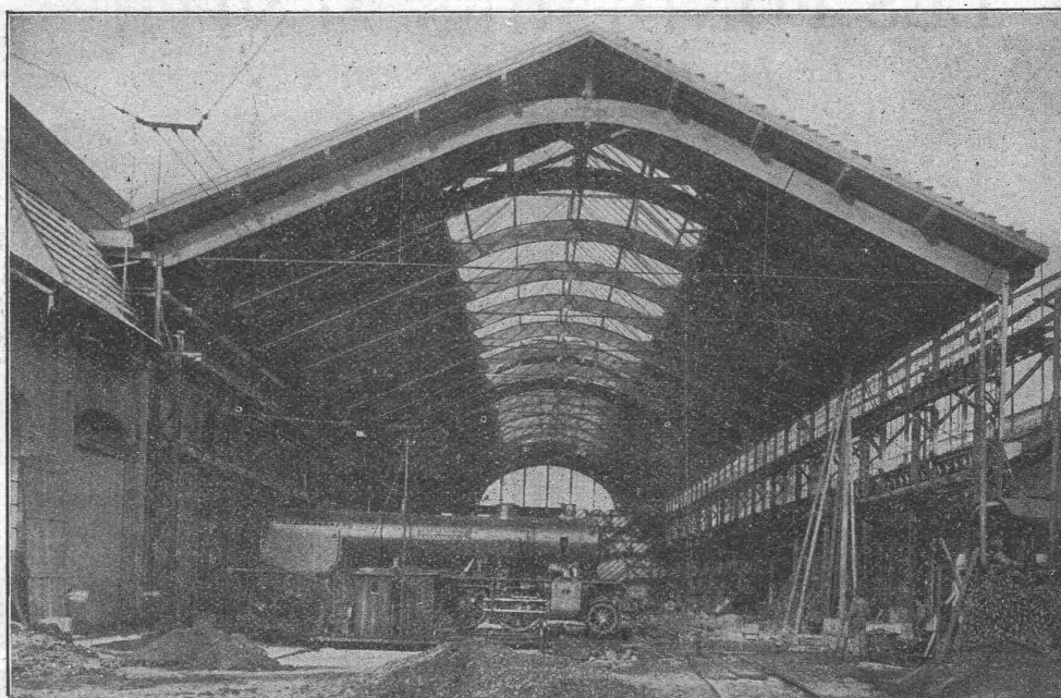
Montagehalle der Schweiz. Lokomotiv- und Maschinentabrik Winterthur. Spannweite der Hetzerbinder 24½ m.
