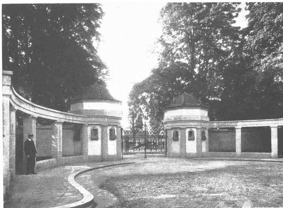
AUSSEN-ANSICHT DES PORTALS MIT VORPLATZ
