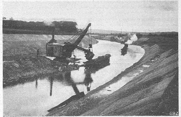
Abb. 48. Kanalpartie bei Km. 9 bis 10 im Bau. An der Böschung rechts Betonverkleidung unvollendet (16. XI. 15).
