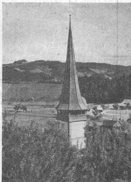
Kirchturm in Signau. Eternit-Doppeldach, kupferbraun.
