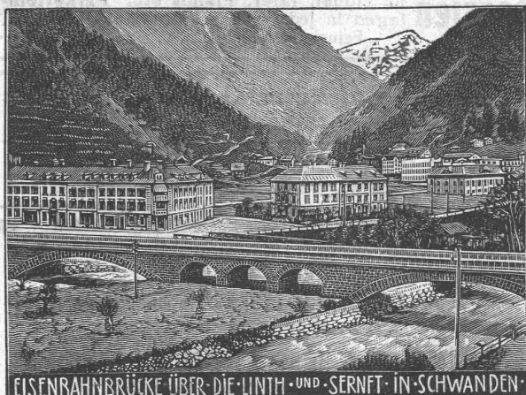
EISENBAHNBRÜCKE ÜBER DIE LINTH-UND-SERNFT-INSCHWANDEN
