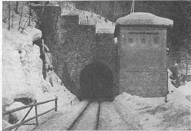
Abb. 15. Schalthäuschen vor dem Solis-Tunnel.
